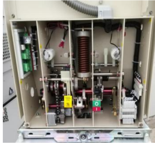
图 6 断路器内置传感器
