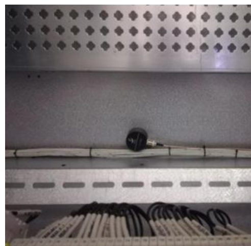
图 4 局部放电传感器
