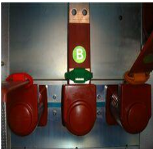
图 3 无线测温传感器
